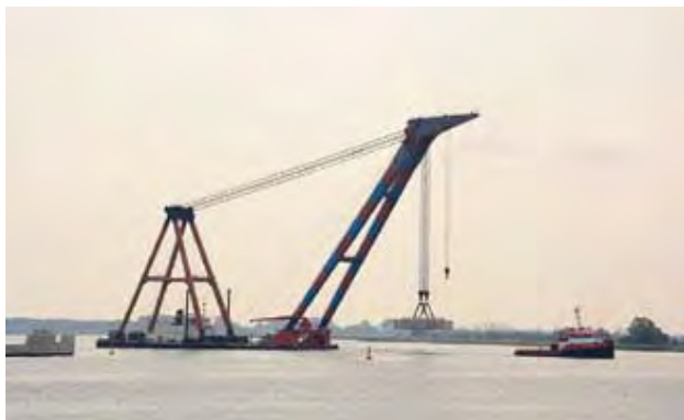
Fot. 5. Transport prefabrykatów – część dolna o masie 540 ton [3]
