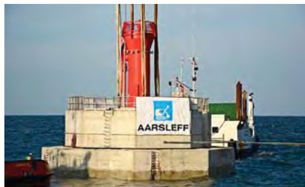
Fot. 8. Montaż prefabrykatów – część górna o masie 380 ton [3]
