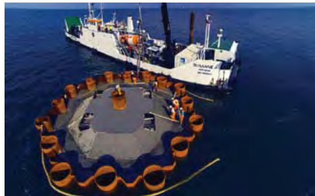
Fot. 4. Wykonanie zasypki i przygotowanie do montażu zwieńczeń [3]
