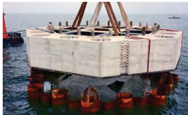
Fot. 6. Montaż prefabrykatów – część dolna o masie 540 ton [3]
