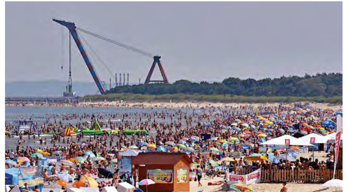
Fot. 9. Dźwig Samson w trakcie transportu górnego prefabrykatu zwieńczenia stawy nr 11 na miejsce wbudowania (FOT. ROBERT IGNACIUK)
