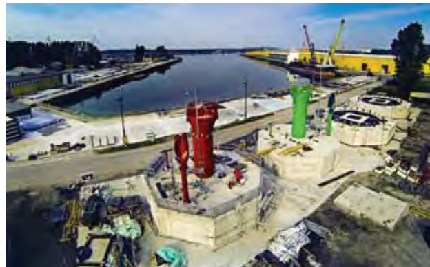
Fot. 2. Betonowanie elementów prefabrykowanych zwieńczeń staw [3]
