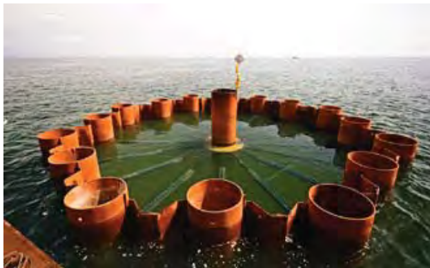
Fot. 3. Montaż ściągów tymczasowych [3]
