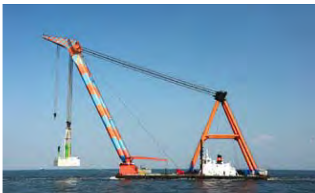
Fot. 7. Transport prefabrykatów – część górna o masie 380 ton [3]
